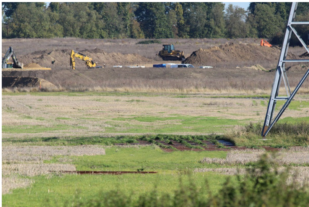
Figur 6 Arbejdet med at gøre klar til højspændingsanlægget nord for Solhøj er i fuld gang.
